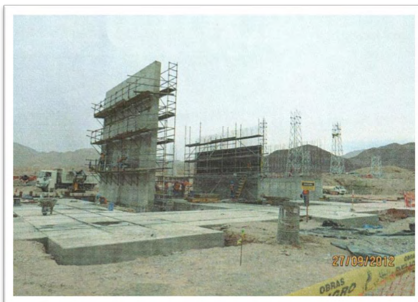
FOTO 2: Avance de construcción de muros cortafuegos y carriles terminados
