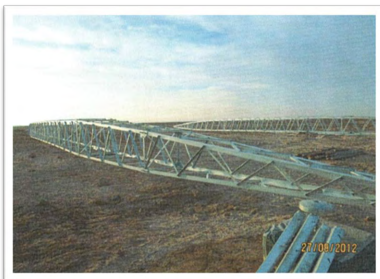
FOTO 5: Mástiles de torre N° 96 completos, pre armados, sobre durmientes de madera.
