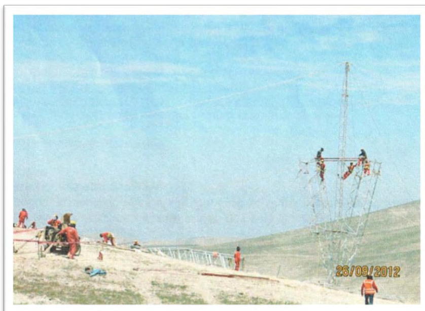
FOTO 6: Montaje de mástiles de torre N° 96
