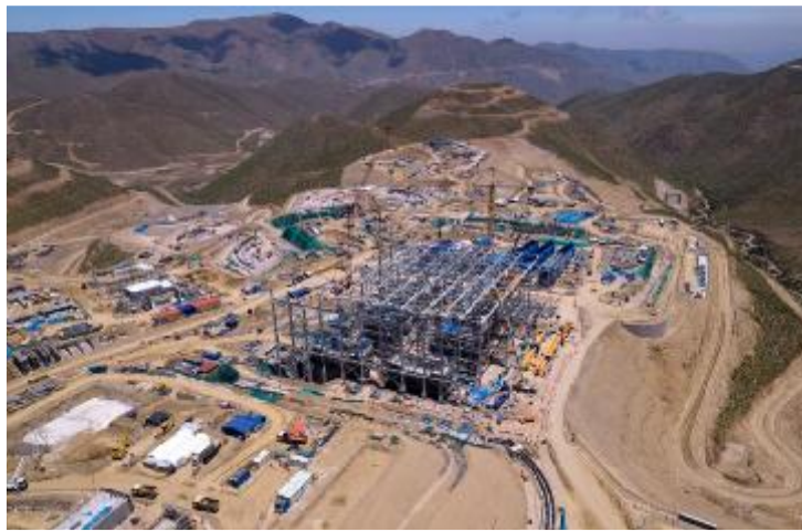
Figura N°21 Minera Anglo American Quellaveco
