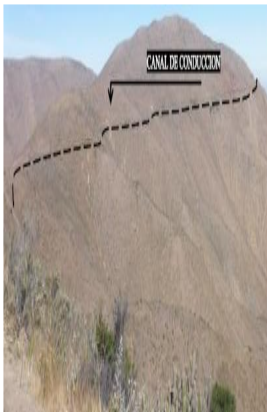
Figura N°43 ÁREA DEL CANAL DE CONDUCCIÓN
