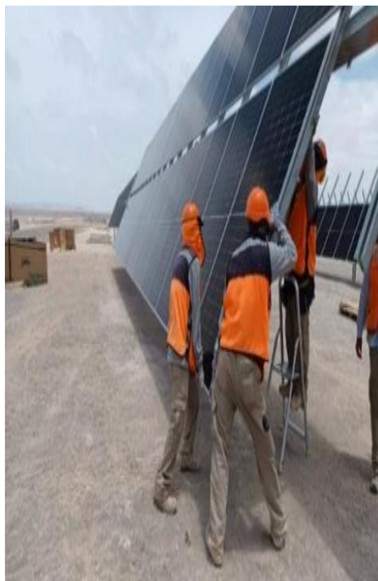
Figura N°25 MONTAJE DE PANELES EN SC-19
