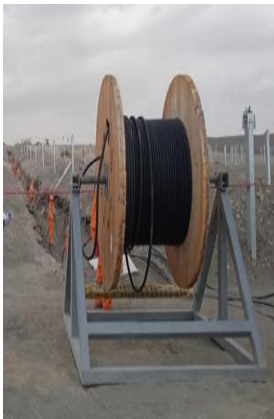
Figura N°24 TENDIDO DE CABLE DE BT EN SC-13
