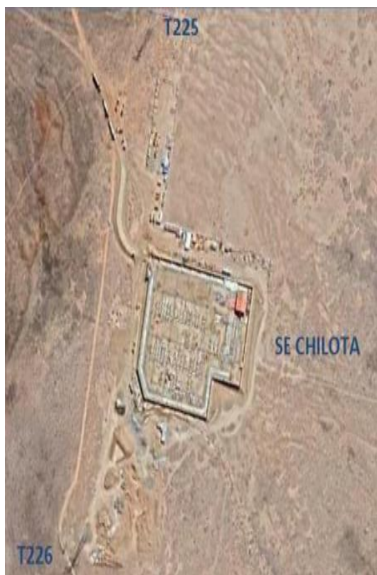
Figura N°48 S.E. CHILOTA EN CONSTRUCCION
