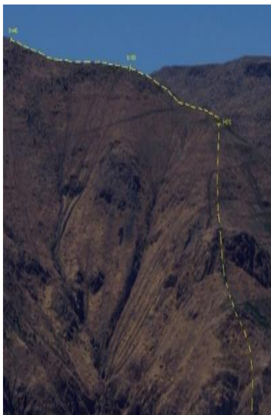
Figura N°42 AREA DE LA TUBERIA FORZADA
