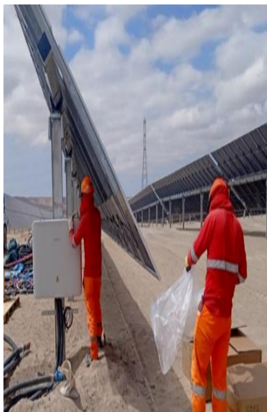
Figura N° 27 MONTAJE DE STRING BOX EN SC-19
